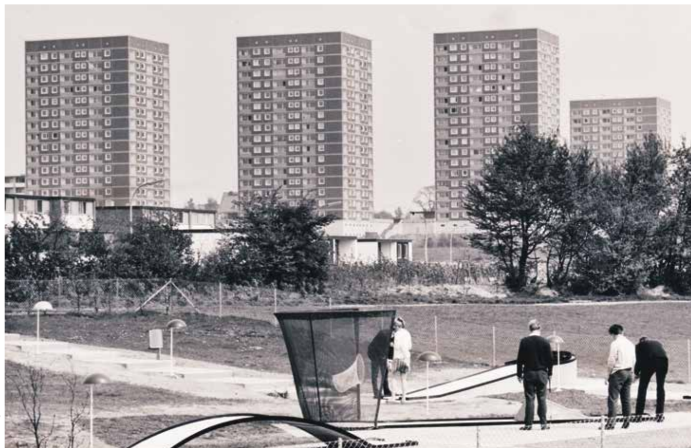
05|02 „Punkthäuser“ – um einen innenliegenden Treppenhaukern entwickelte mehrgeschossige Gebäude – in der Siedlung Lohbrügge-Nord (Foto von 1968).
