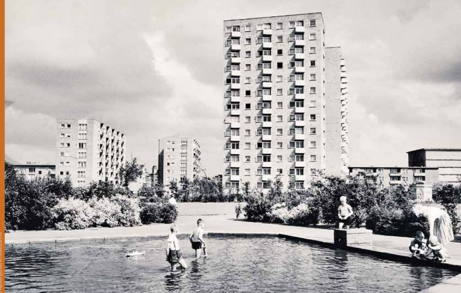
04|07 Nach Trümmerräumung und Abriss bestehender Gebäude konnte Ernst May entlang der Holstenstraße „die Baukörper frei im Raum gruppieren“ (Foto von 1961).
